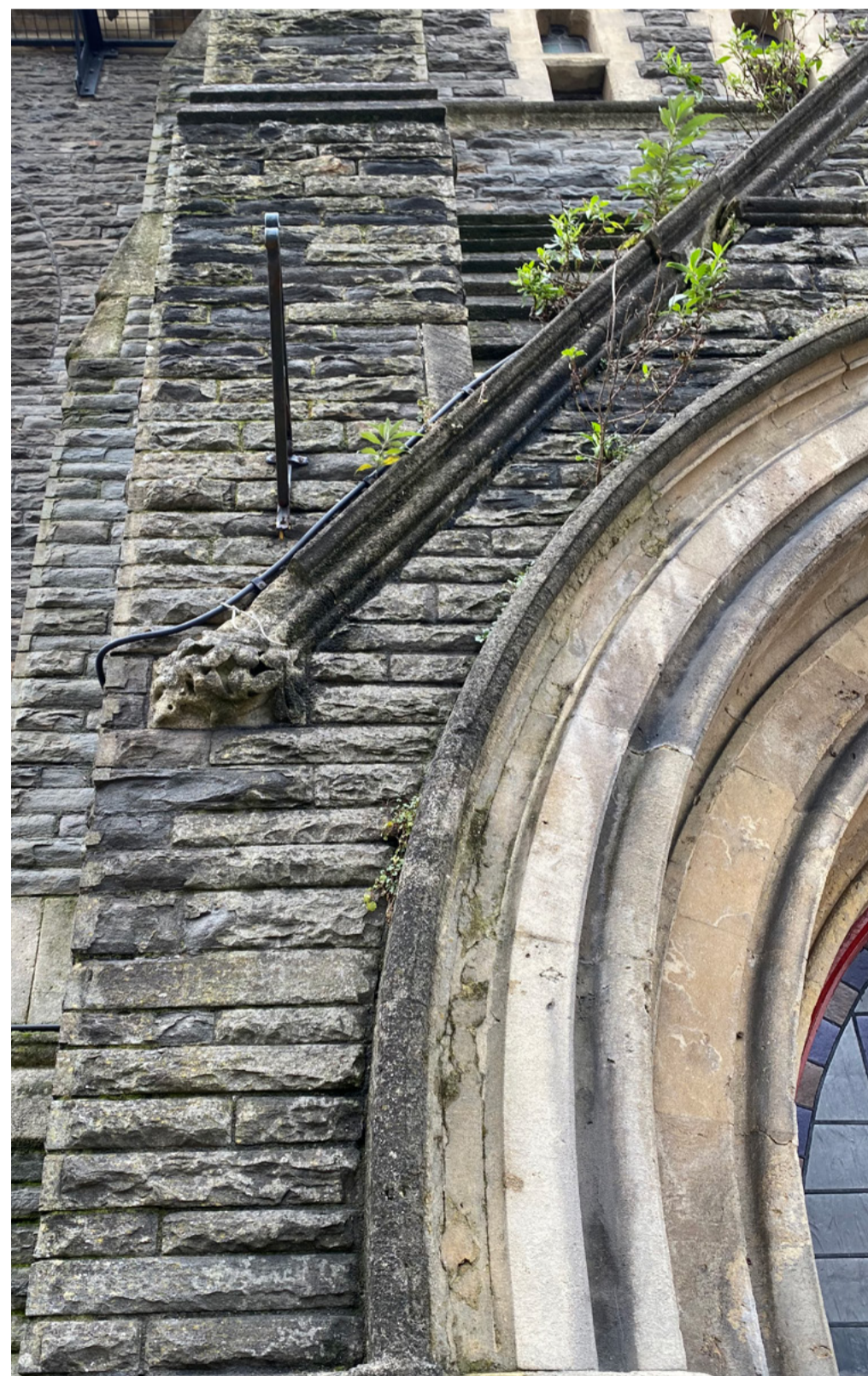
Tyfiant ar Barpedau a Chymalau Mortar
