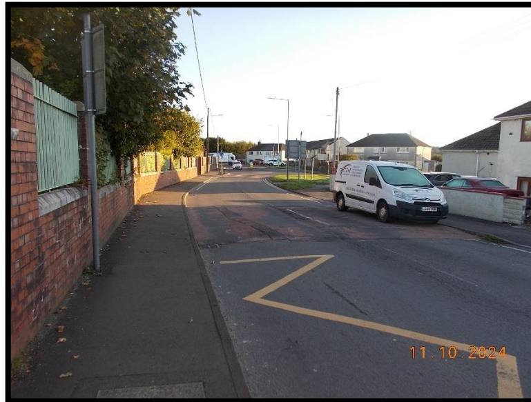
Ffotograff 4.28 – Cyswllt man croesi heb ei reoli dros y twmpath cyflymder presennol (ger allanfa'r ysgol) wedi'i rwystro gan barcio ar y stryd
