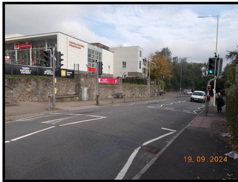
Ffotograff 4.29 – Croesfan a reolir gan signalau y tu allan i adeilad Prifysgol De Cymru
