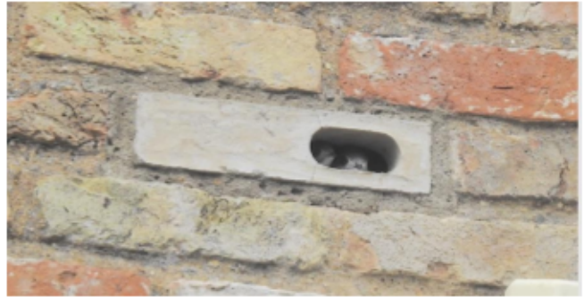
"S-Brick" ym mur tŷ wedi'i gwneud gan Gweithredu dros Wenoliaid Duon (Dick Newell)
